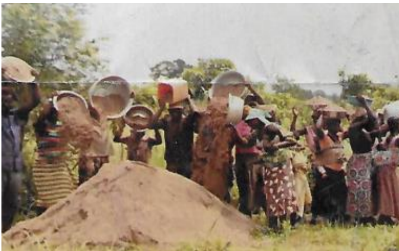
Eltern von Akana-Copé beim Aushub des Fundamentes für das neue Schulhaus
