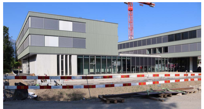
Auch beim Erweiterungsgebäude Ost werden noch Arbeiten ausgeführt – aussen beispielsweise Teile der Umgebungsgestaltung.
