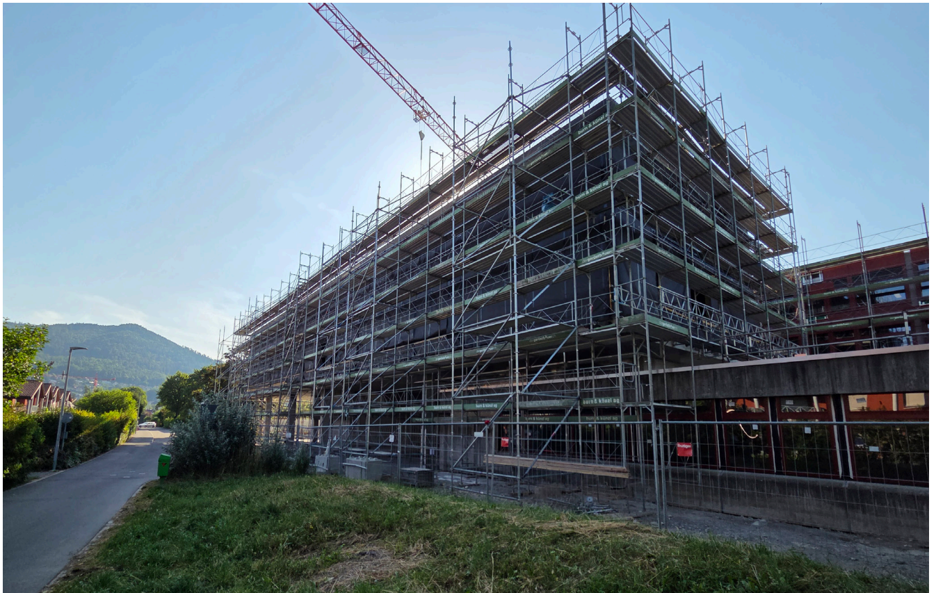
Beim Erweiterungsbau Nord sind noch Arbeiten an der Gebäudehülle ausstehend.
